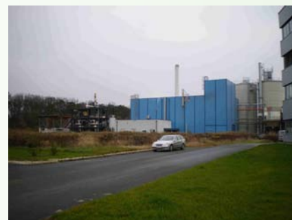
Bioenergieanlagen-Park am EEE
